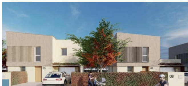
20 logements à Canteleu livrables en 2026
