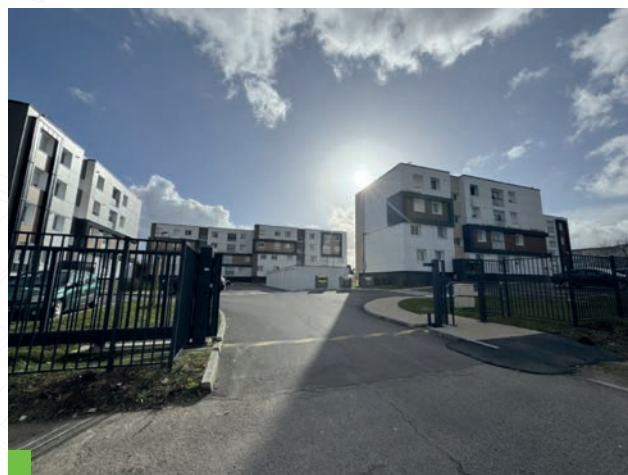
Livraison de Résidentialisation de la Résidence des Oiseaux à OISSEL
