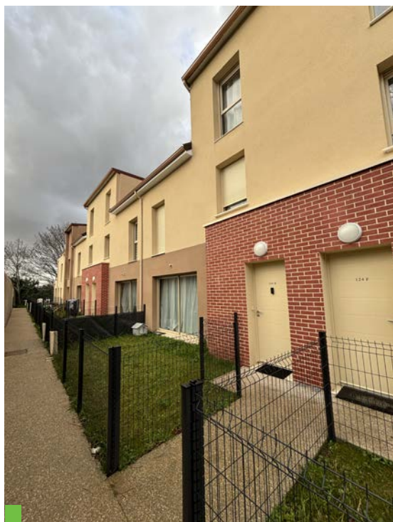
Livraison de 7 logements au PETIT-QUEVILLY
