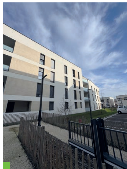
Livraison de 21 logements à DÉVILLE-LÈS-ROUEN
